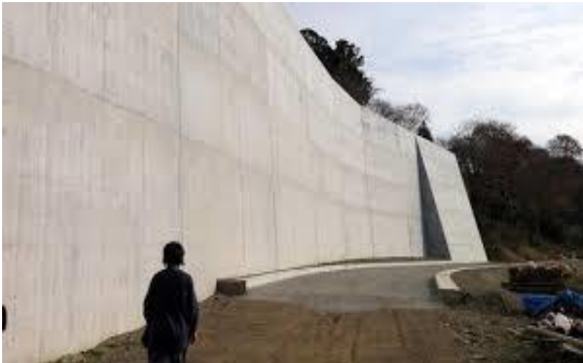
Neu errichtete Betonschutzmauer an der Ostküste Japans.
