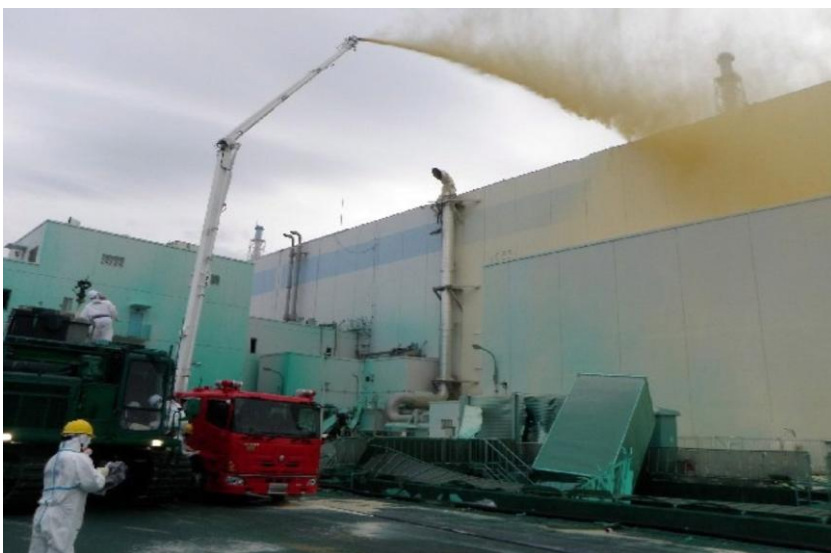
Besprühung der Werksgebäude mit Kunstharz
